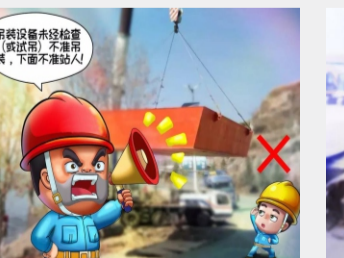
设备吊装作业前，应先对设备进行检查，确认设备性能完好。起吊前，应先进行试吊，吊装过程中，下方不准站人
